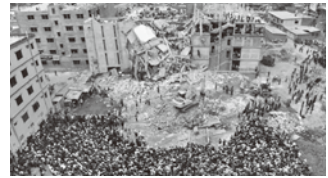
バングラデシュの首都ダッカ近郊サバルで 崩落した縫製工場ビルの救助作業 (2013年4月25日撮影) ©AFP=時事
